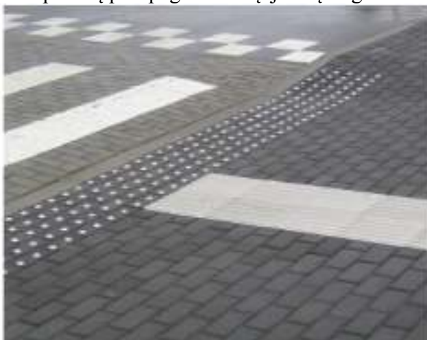
1 pav. Išpėjamųjų paviršių įrengimas prieš laiptų aikštelės
