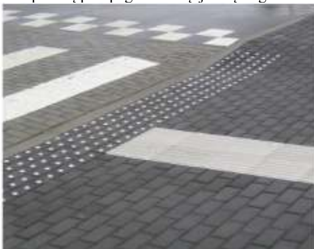
1 pav. Išpėjamųjų paviršių įrengimas prieš laiptų aikštelės
